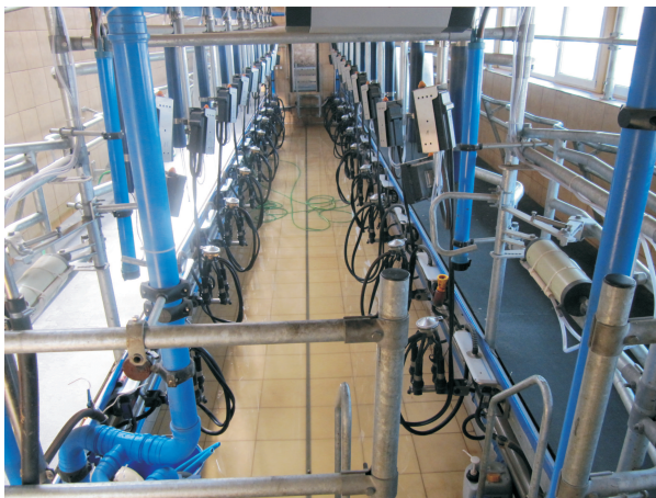
Hala udojowa po modernizacji – Chorzelów
