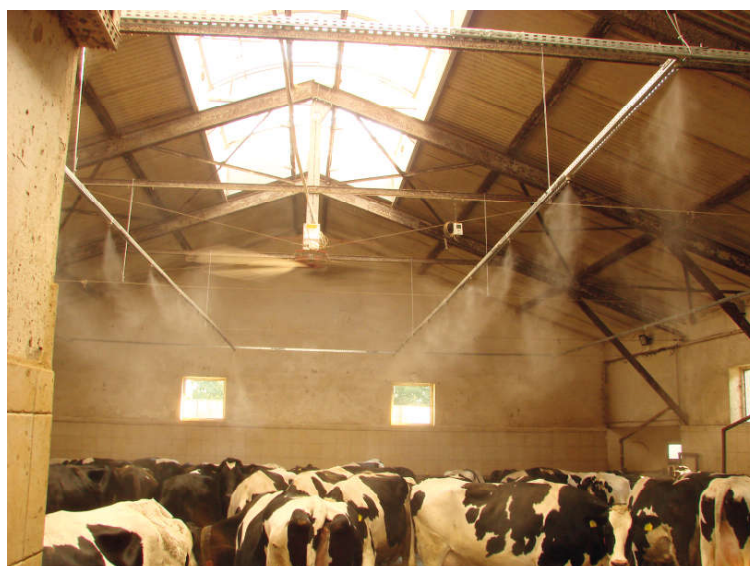
Fot. 5. System zamgławiania w poczekalni dla krów Phot. 5. Fogging system in cow waiting area
