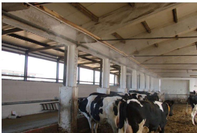
Fot. 4. System zamgławiania nad korytarzem karmowo-gnojowym w oborze kurtynowej Phot. 4. Fogging system above feeding/dunging passage in curtain-sided barn
