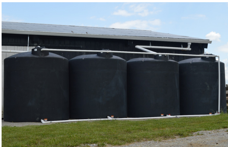
Fot. 2. Zbiorniki do magazynowania wody deszczowej z powierzchni dachu obory (fot. S. Higgins i wsp. – Providing water for beef cattle in rotational grazing system , 2016)
