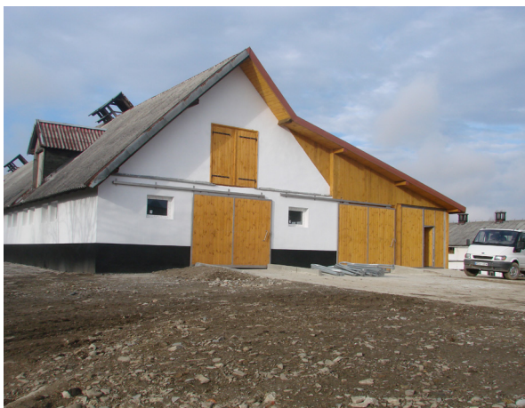
Zmodernizowany jałownik przekształcony na oborę wolnostanowiskową, ZD Odrzechowa
